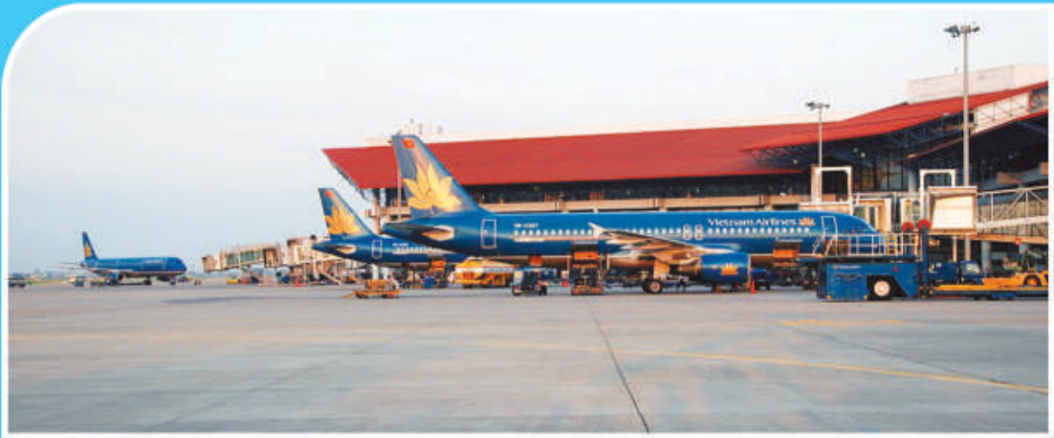
Nhà ga T2 - Sân bay Quốc tế Nội Bài - Noi Bai International Airport
