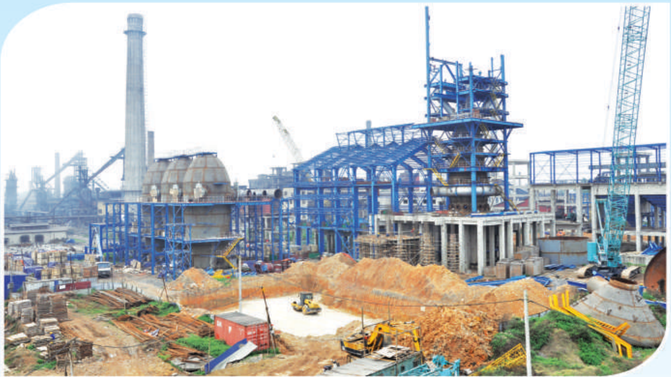
Các công trình thuộc dự án đầu tư mở rộng sản xuất giai đoạn II đang trong quá trình xây dựng lắp đặt và hoàn thiện. Other constructions in the investment project of production expansion - stage II) have been in process of installation and completion.
