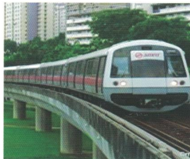
Đường sắt trên-cao Cat Linh- Ha Dong railway
